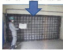
▲施工中①: アンカー・鉄筋配筋
