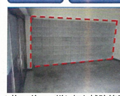
▲施工前: RC増し打ち補強箇所
