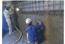
▲施工中②: 吹付け状況
