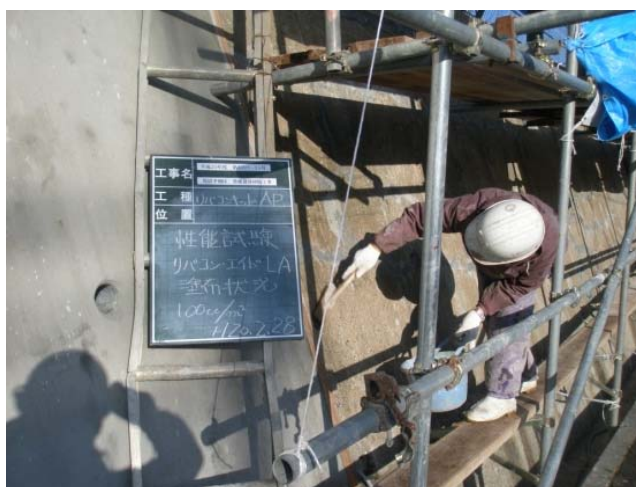
Gブロック リバコン・リキッド塗布状況
