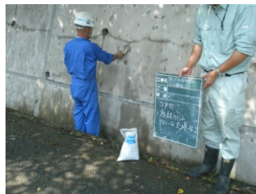
孔口復旧状況
